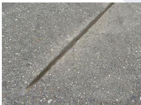
将施工地面划出可埋入磁条的缝隙
